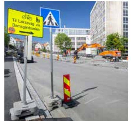
Under bygging: Sykkelfelt og fortau i Carl Konows gate. Foto: Silje Drevdal
