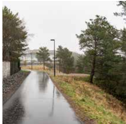
Ny gang og sykkelveg mellom Såtabu og Helsehuset i Alver Foto: Thor Brødreskift
