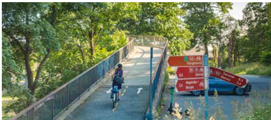
Planlegges: Sykkelstamveg Bergen, delstrekning 4, Fjøsanger–Kristianborg. Foto: Silje Drevdal
