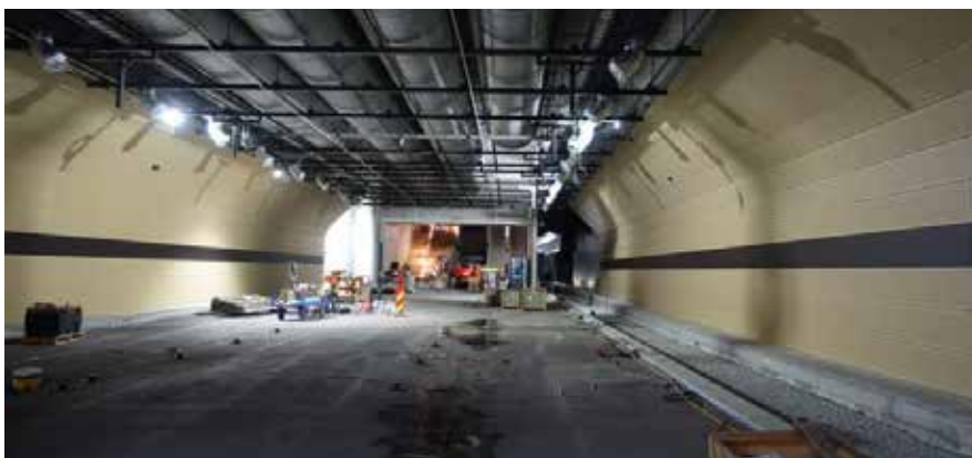
Bybanen under arbeid: Underjordisk holdeplass Haukeland Sykehus. Foto: Bybanen utbygging
