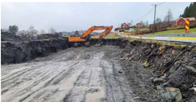
Arbeidet med ny trafiksikker infrastruktur i Sagstadvegen starta opp i 2023. Foto: ...
