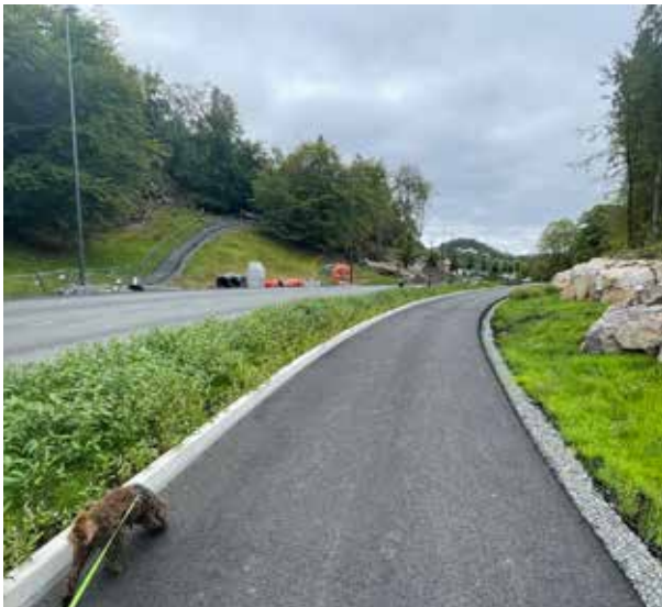
Håkonshellavegen blir opprustet, og ventes å stå ferdig våren 2024. Foto: Vestland fylkeskommune
