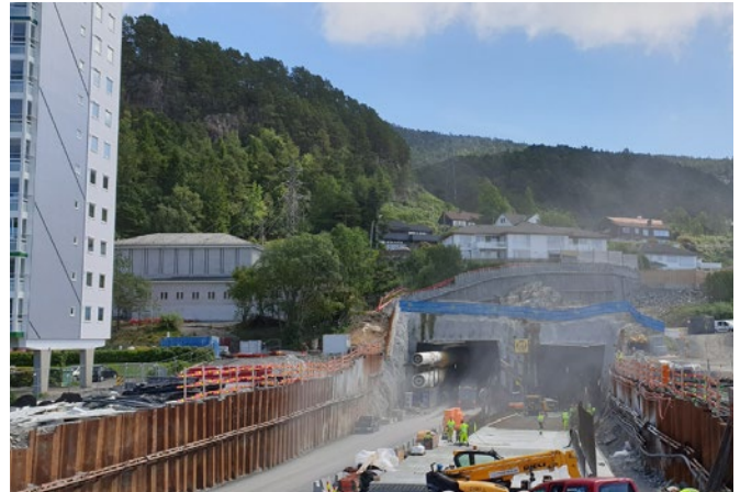
Under arbeid: Tunnelinnslag Fyllingsdalstunnelen, sett fra Oasen, juni 2019. Foto: Ingrid Feet Bjørge
