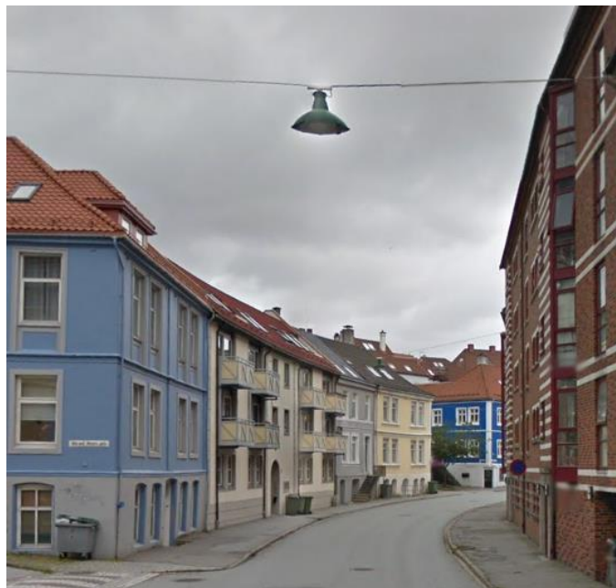
Figur 4-5: Typisk vaiermontert belysning i Sandviken, spent opp over gateløpet. Her fra Nye Sandviksvei. Foto: Google streetview.
