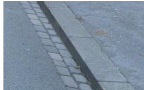
Figur 4-3: Prinsipp for gjennomgående kant på strekningen.
