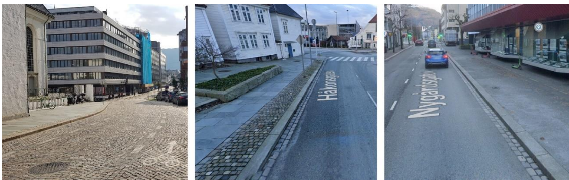
Figur 4-1: Eksempler på ulike gateromsstandard. Fra venstre: Natursteinsdekker i hele gateprofilet (Strandgaten). Midten: Asfaltert kjørebane og natursteinsdekke på fortau (Håkonsgaten) Til høyre: Asfaltert kjørebane skilt fra asfaltert fortau med granitkant og rennestein (Nygårdsgaten). (Foto: Til venstre NOAV, midten og høyre: Google Streetview.)
