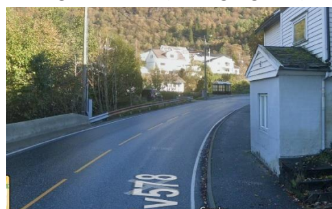
Figur 2-5: I krapp sving langs Ervikveien ligger bebyggelsen tett på vegen og gir et svært smalt fortau tett på bolig. (www.google.no)
