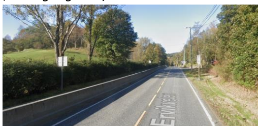
Figur 2-8: Gang/ sykkelvei langs Ervikveien fra butikken og nordover. Betongrekkverk og få steder å krysse medfører tråkk langs østside av veg. (www.google.no)
