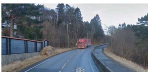
Figur 2-12: Ensidig areal for mange trafikanter langs østsiden av Ervikveien fra Åstveitveien til Tertneskrysset. Deler av strekket er adskilt med betonggjerdje. (www.google.no)
