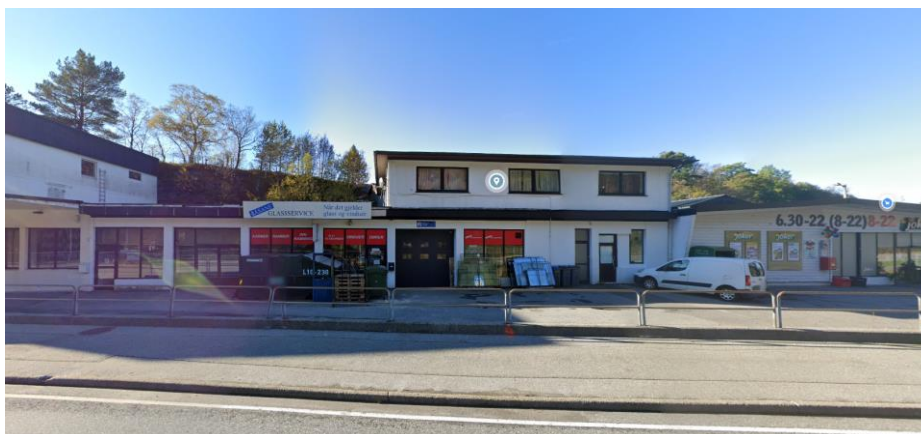
Figur 4-11: Dagens situasjon for Ervikveien 72 med porter og parkering mot øst. Fra www.google.no
