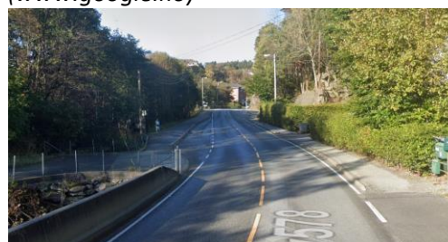
Figur 2-9: Ervikveien nord for Sjurastemma har overgang fra gang/ sykkelveg til tosidig fortau og åpen bekk på vestsiden. (www.google.no)
