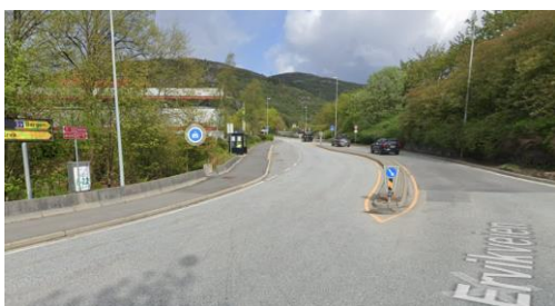
Figur 2-2: Ensidig fortau sør i Eidsvåg (www.google.no)
