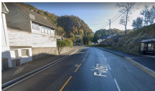
Figur 2-6: Ervikveien like før kryss til Stallkleiven, tosidig fortau i forbindelse med busslomme. Smalt fortau tett på bolig (www.google.no)
