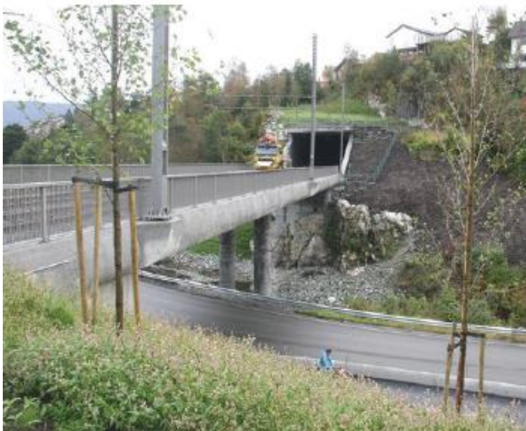
Figur 48: KL-master over bru, fra Prosjekteringsveilederen for Bybanen
