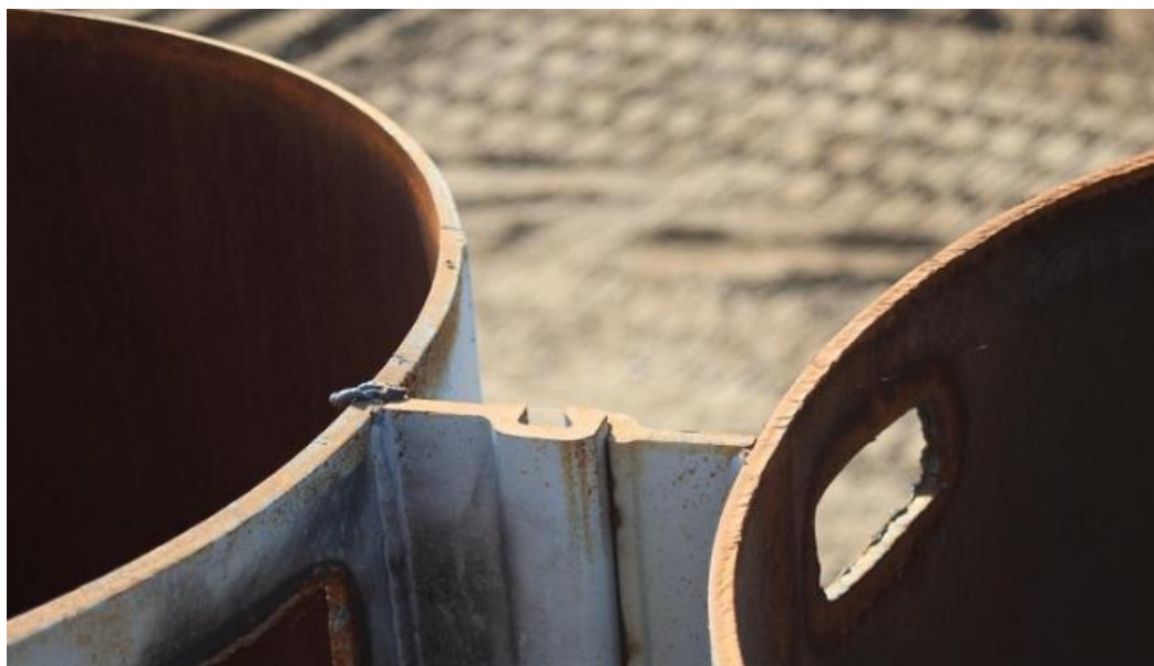
Figur 6 Skjøting mellom rørene i rørspuntvegg.
