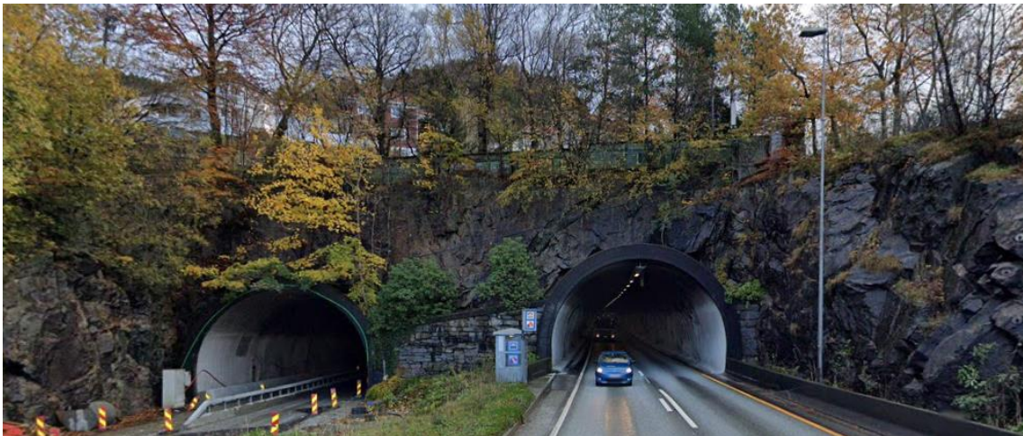
Figur 4-10: Foto av bergmassen i påhuggsområdet ved Sandviken sykehus. Eksisterende nordgående Fløyfjelltunnel til høyre, eksisterende Munkebotntunnel til venstre.
