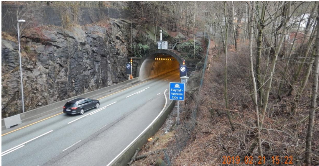
Figur 4-7: Foto av bergmassen i påhuggsområdet ved Amalie Skrams vei. Tunnelmunning for eksisterende sørgående Fløyfjell-tunnel vises. Skjæringen til venstre i bildet skal utvides. Bybanetunnelen skal gå under ny vei inn mot rampetunnelene til forlenget Fløyfjell-tunnel.
