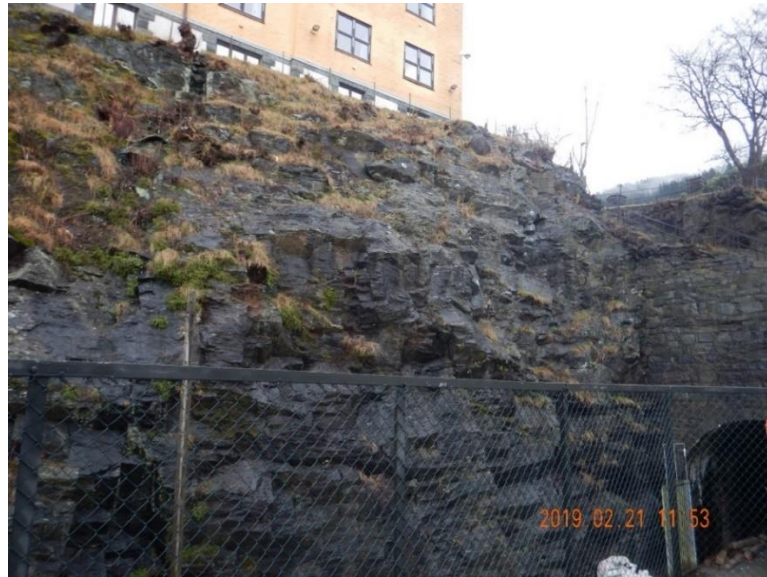
Figur 4-1: Foto av bergmassen i påhuggsområdet i Sandbrogaten. Koengen jernbanetunnel i bakgrunnen.
