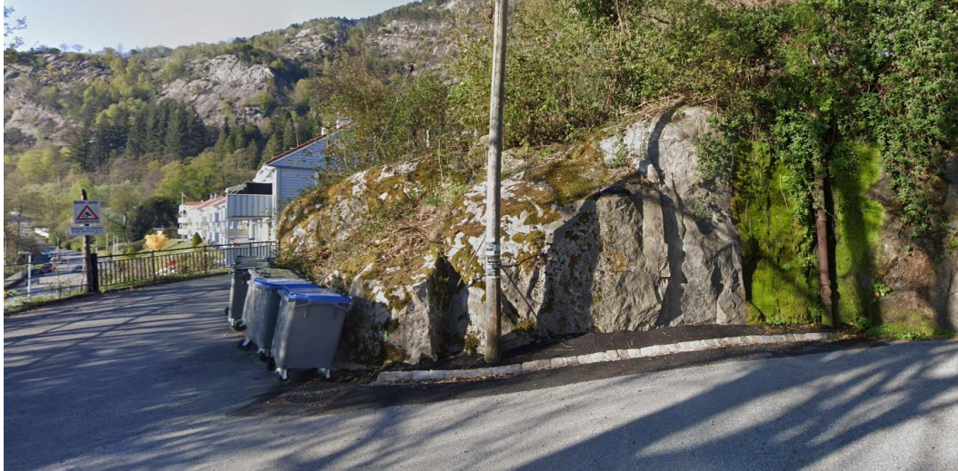
Figur 4-3: Foto av bergmassen i påhuggsområdet i krysset Amalie Skrams vei / Formanns vei.
