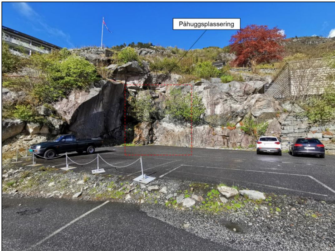
Figur 4-1: Oversiktsfoto over påhuggsområde for anleggstunnel fra Saltimport-tomten.
