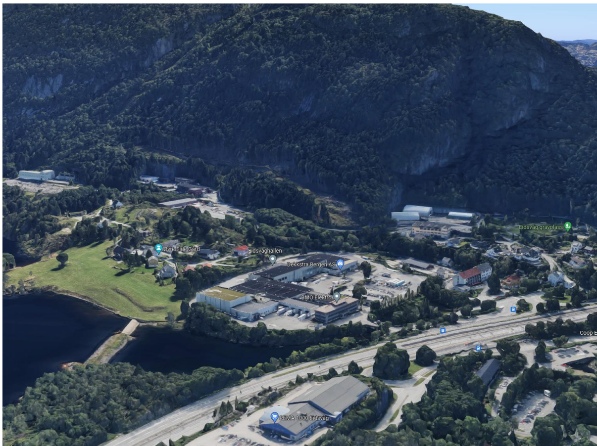
Figur 3-5 Arealet for framtidig rigg- og anleggsområde i Eidsvåg, vist på skjermdump fra jordklodevisningen til Google maps, sikretning sørover.
