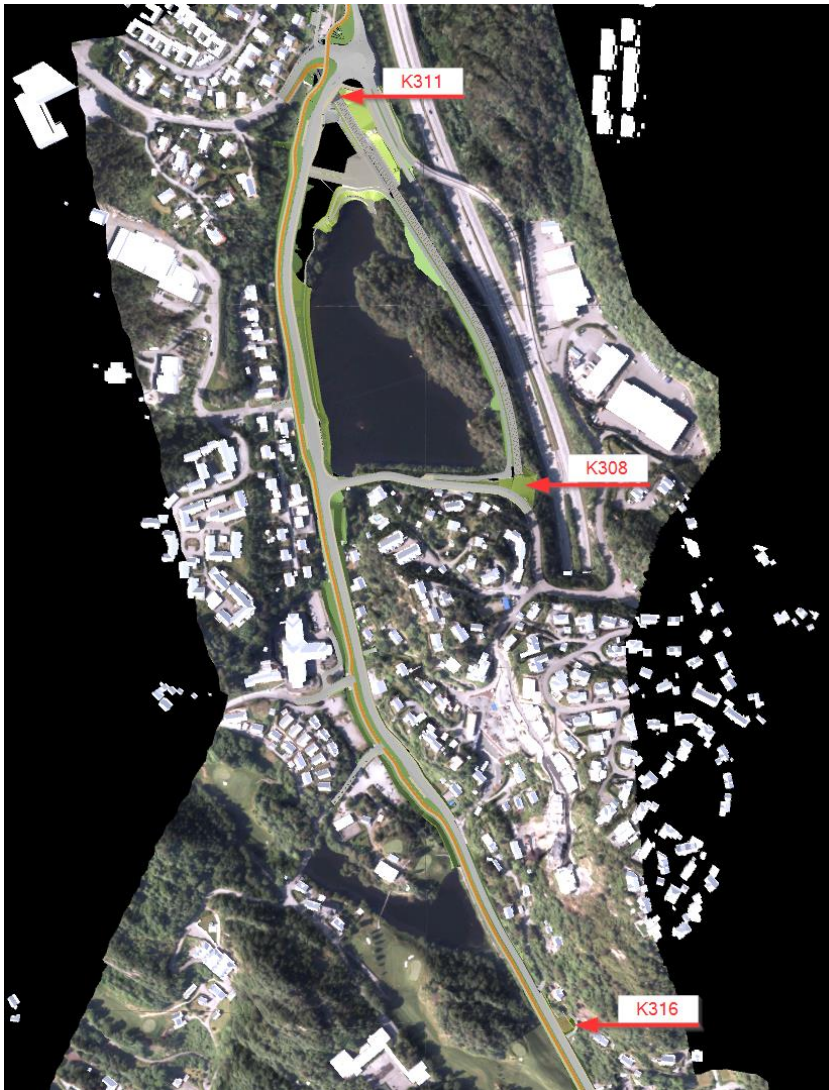
Figur 24: Illustrasjon for plassering av konstruksjoner i Ervikveien og rundt Griggastemma Konstruksjonene skal utformes etter Bybanens gjeldende tekniske regelverk. De skal også følge retningslinjer fra Statens Vegvesens håndbok N400 «Bruprosjektering», og alle tilhørende håndbøker, samt at de skal utformes etter prosjekteringsreglene i Eurokode-serien.
