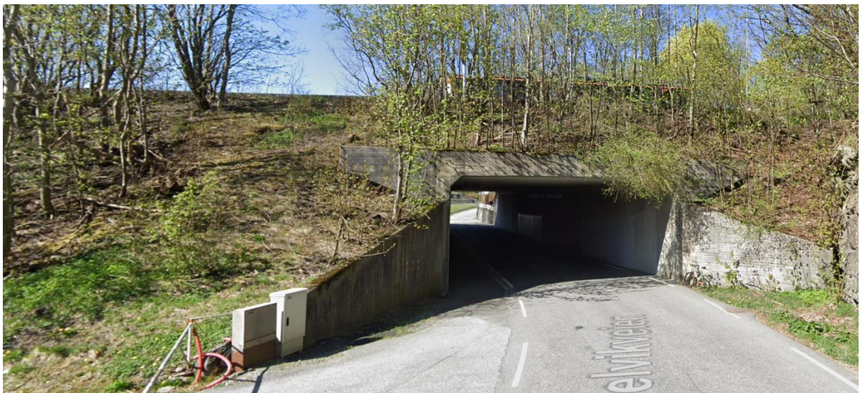
Figur 29: Bilde av eksisterende kulvert.
