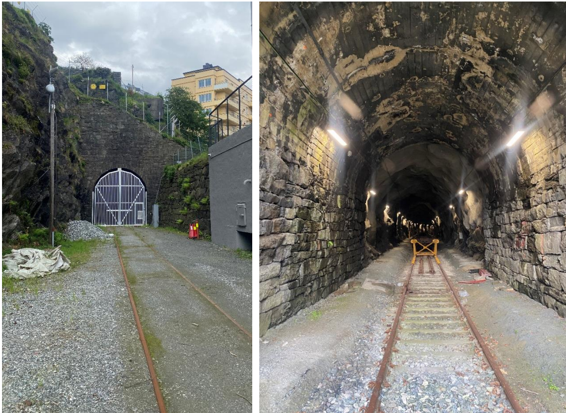
Figur 1-1: Portal med port sett fra Koengen (venstre) og første del av portal sett fra tunnelåpning (høyre)
