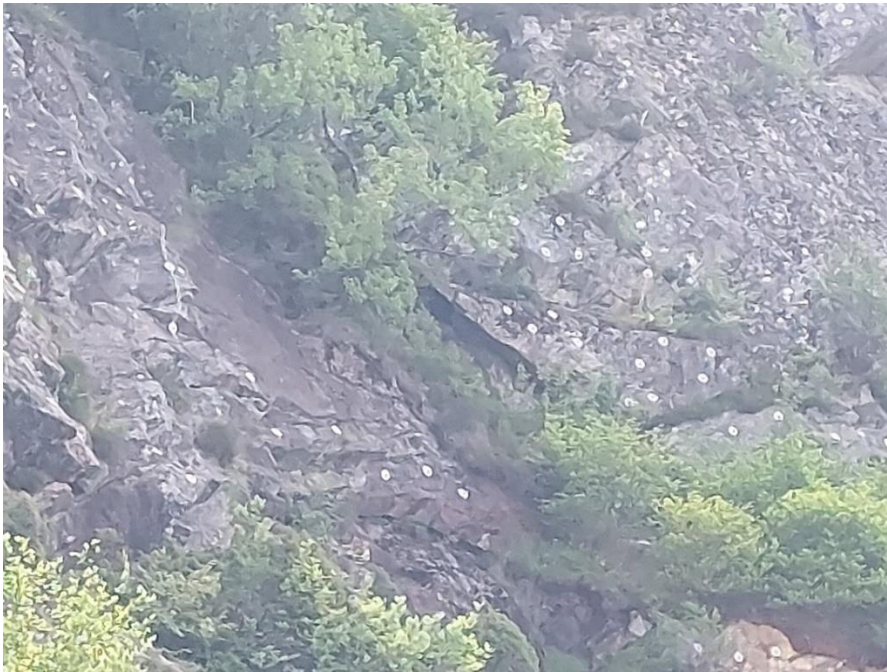
Figur 6.3-9 Tett bolting av fjellsiden mot øst ved Glasskaret - foto med zoom
